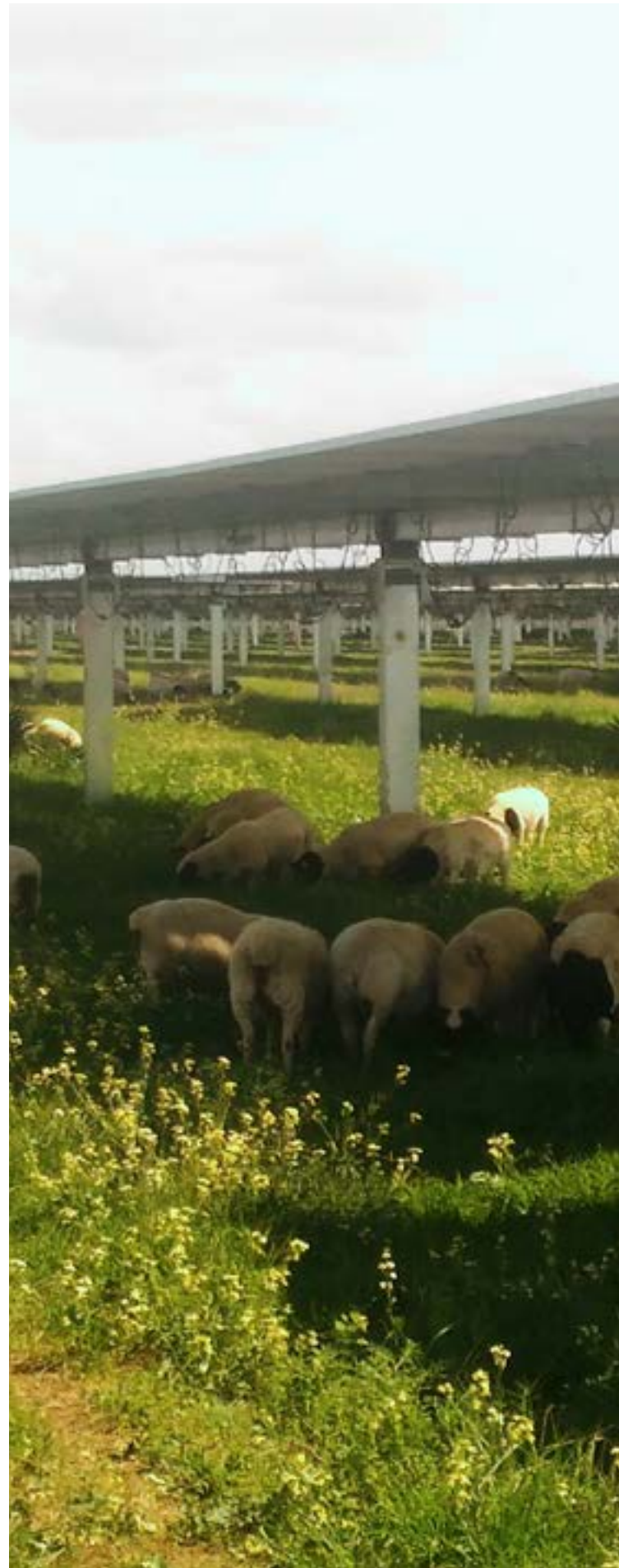
Planta solar en Australia, 70 MW.
