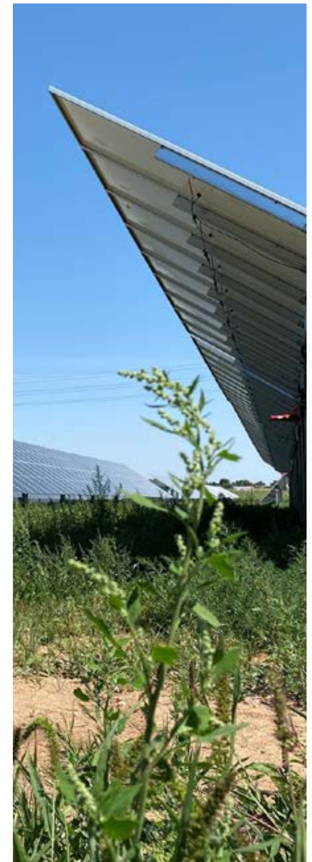
Planta solar en España, 5 MW.
