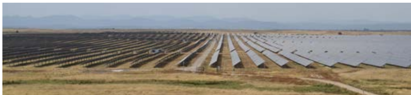
Planta solar en España, 300 MW.
