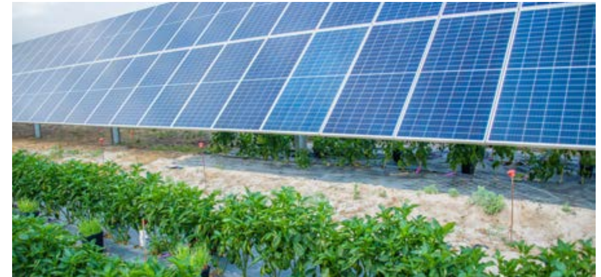
Planta solar en España, 85 MW.
