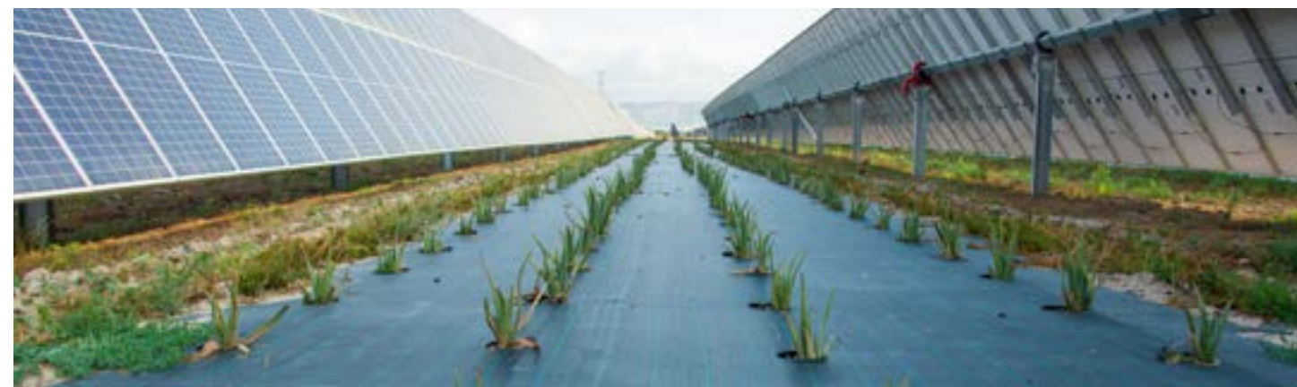
Planta solar en España, 85 MW.
