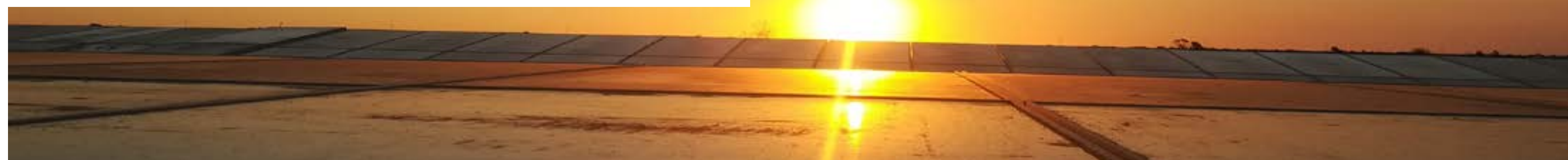
Planta solar en Namibia, 48 MW.
