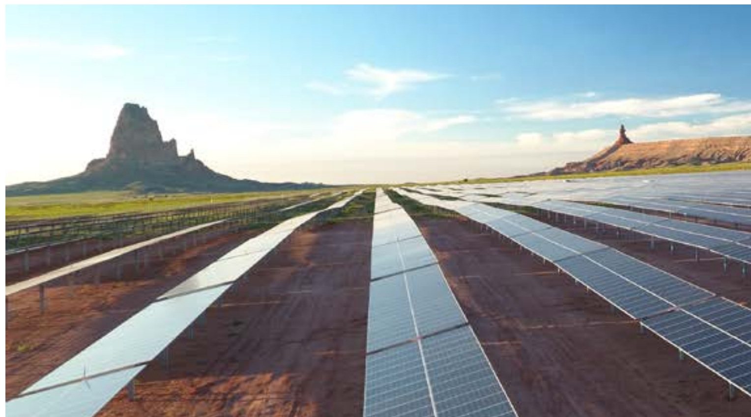
Planta solar en Estados Unidos, 38 MW.
