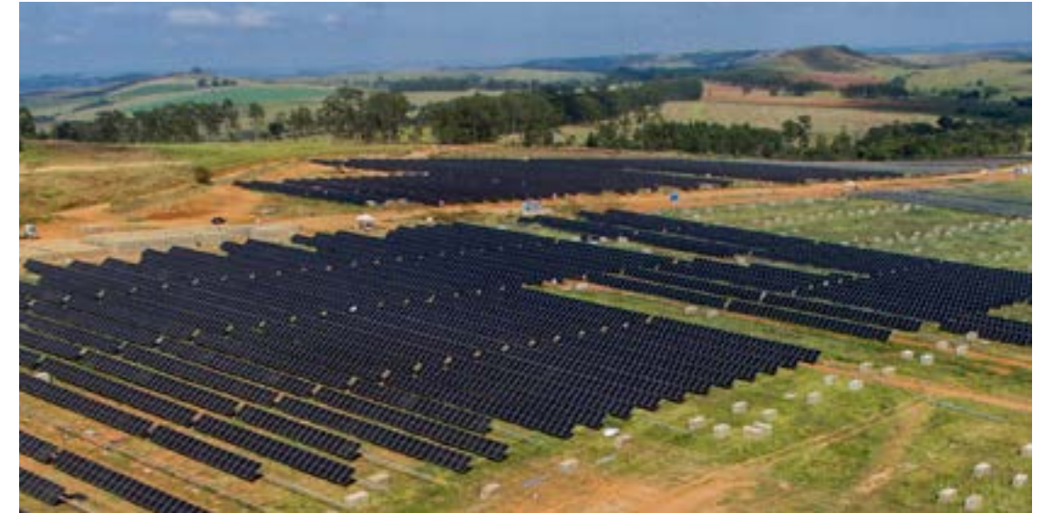
Planta solar en Brasil, 113 MW.
