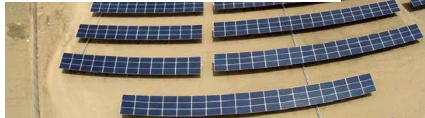
Planta solar en Chile, 12 MW.
