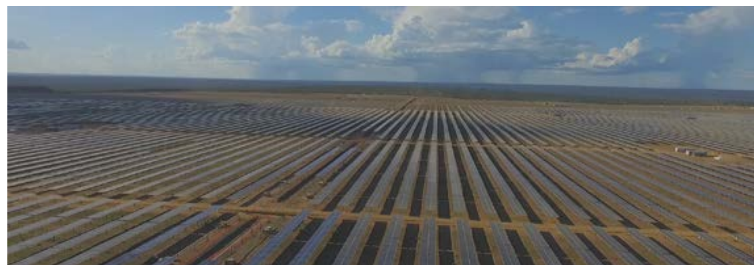
Planta solar en Brasil, 292 MW.
