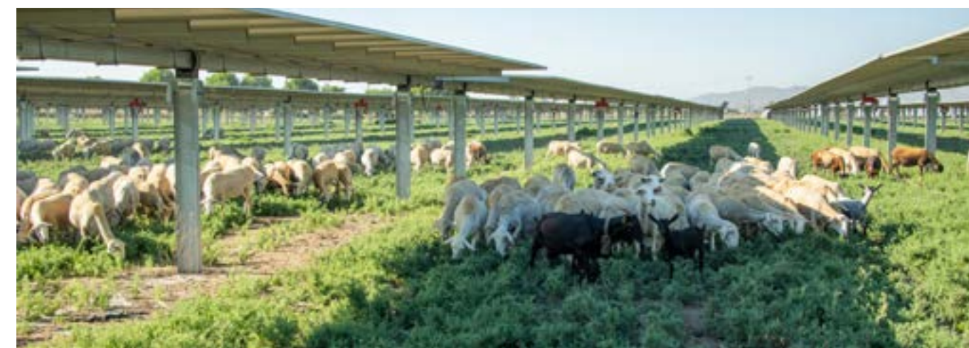
Planta solar en España, 85 MW.
