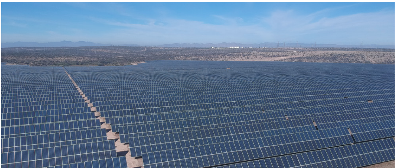
Foto: Planta solar en España.
