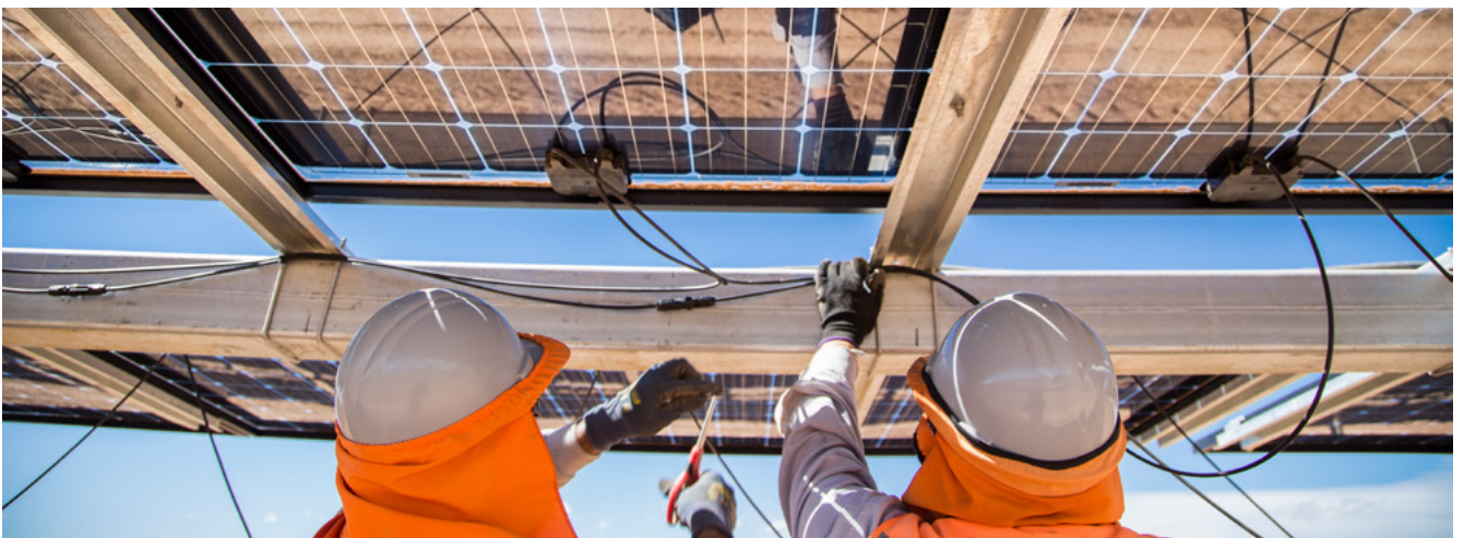
Foto: Operarios instalando un seguidor solar.
