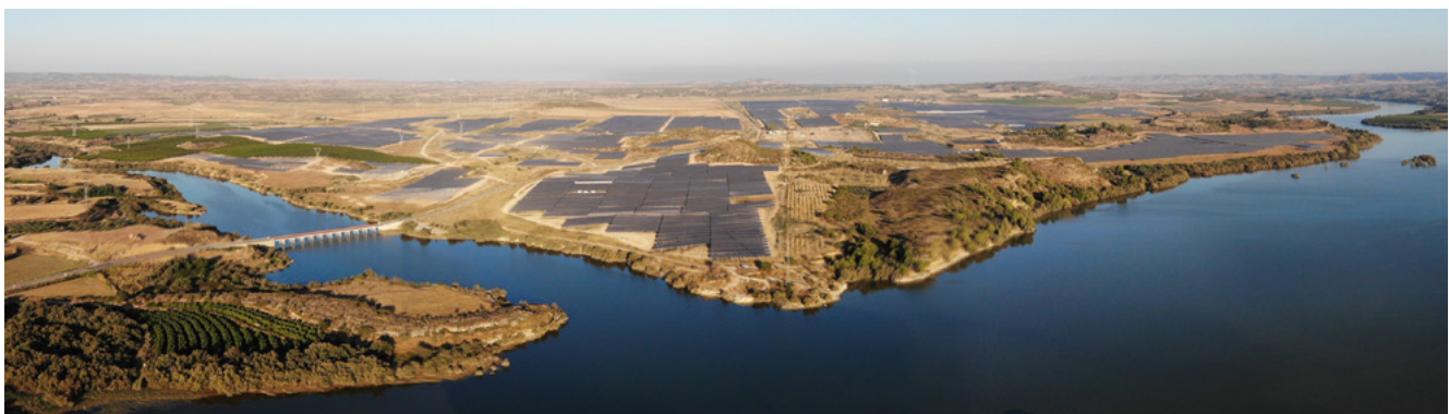
Foto: Planta solar en España.
