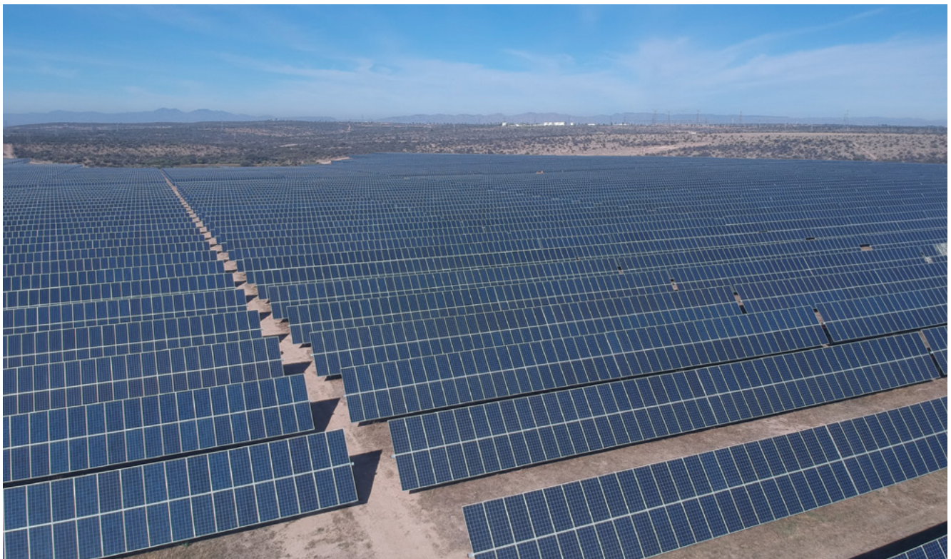
Foto: Planta solar en España.
