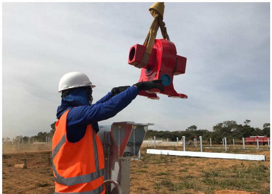
Foto: Operario de Soltec instalando un seguidor solar.
